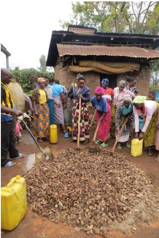
Een groep werkt samen aan de bouw van een nieuwe tank
